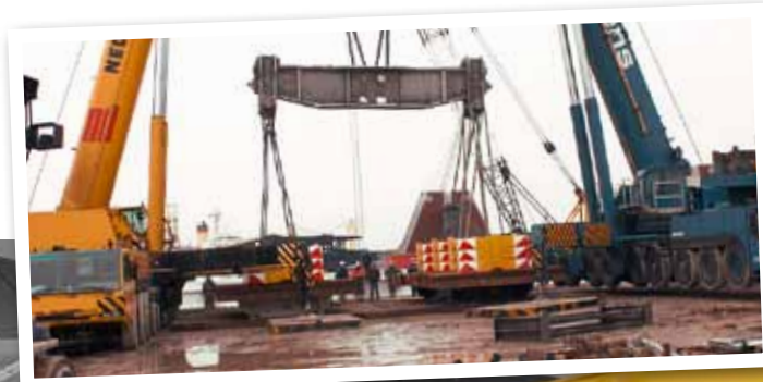
Traversentest gestern und heute: Was einst im „Feldversuch“ getestet wurde, wird nun bei Axzion unter idealen Bedingungen durchgeführt: Am Prüfstand können Traversen und Anschlagmittel bis 600 t Tragkraft geprüft werden.
