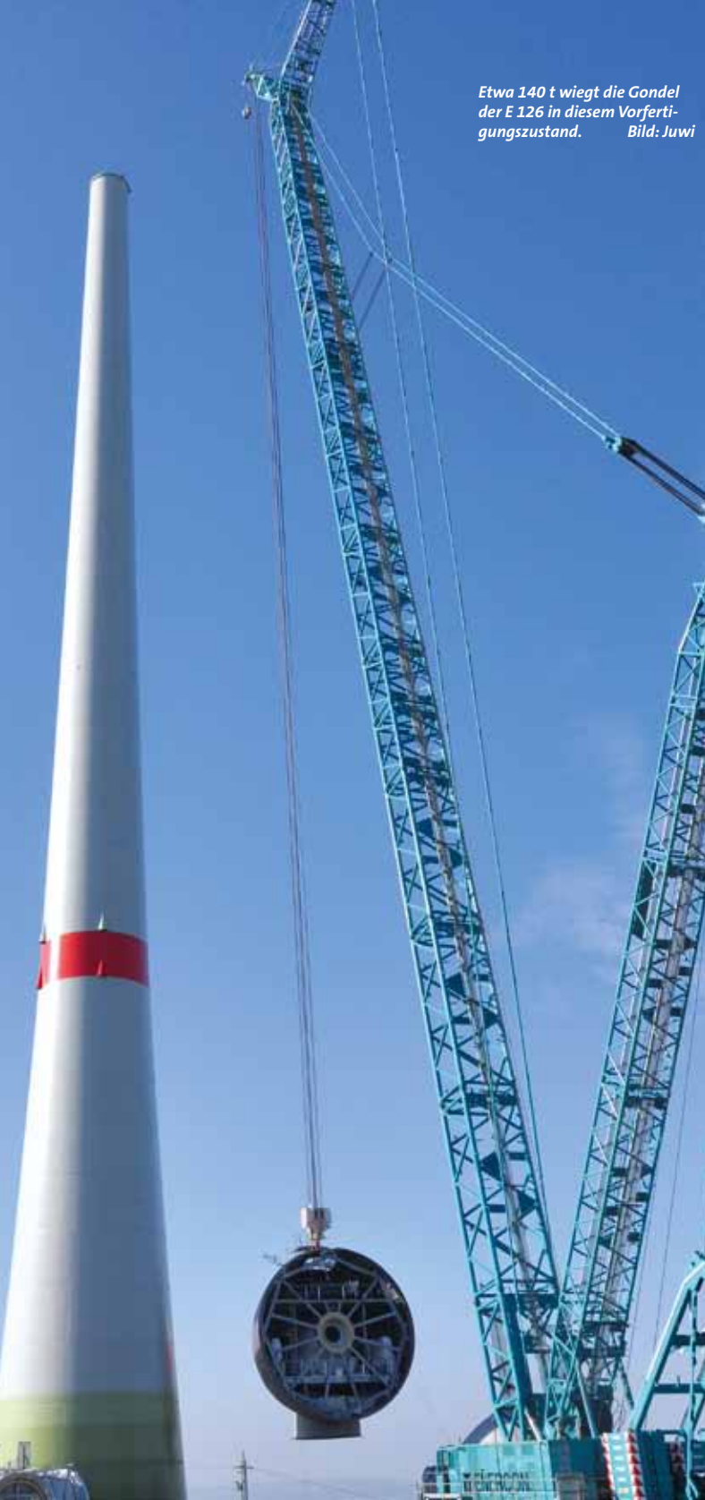
Mensch und Maschine halten die Last mit Führungsseilen auf Kurs. Bild: HSMS
