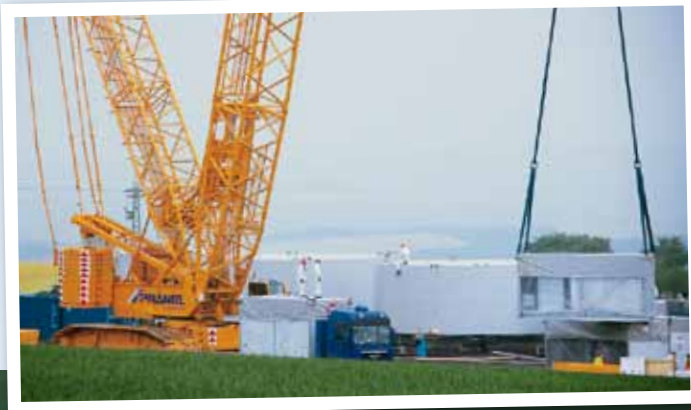
Zur Montage des Turms wurde ein CC 2800 eingesetzt. Bilder: Juwi (Luftbild) / HSMS
