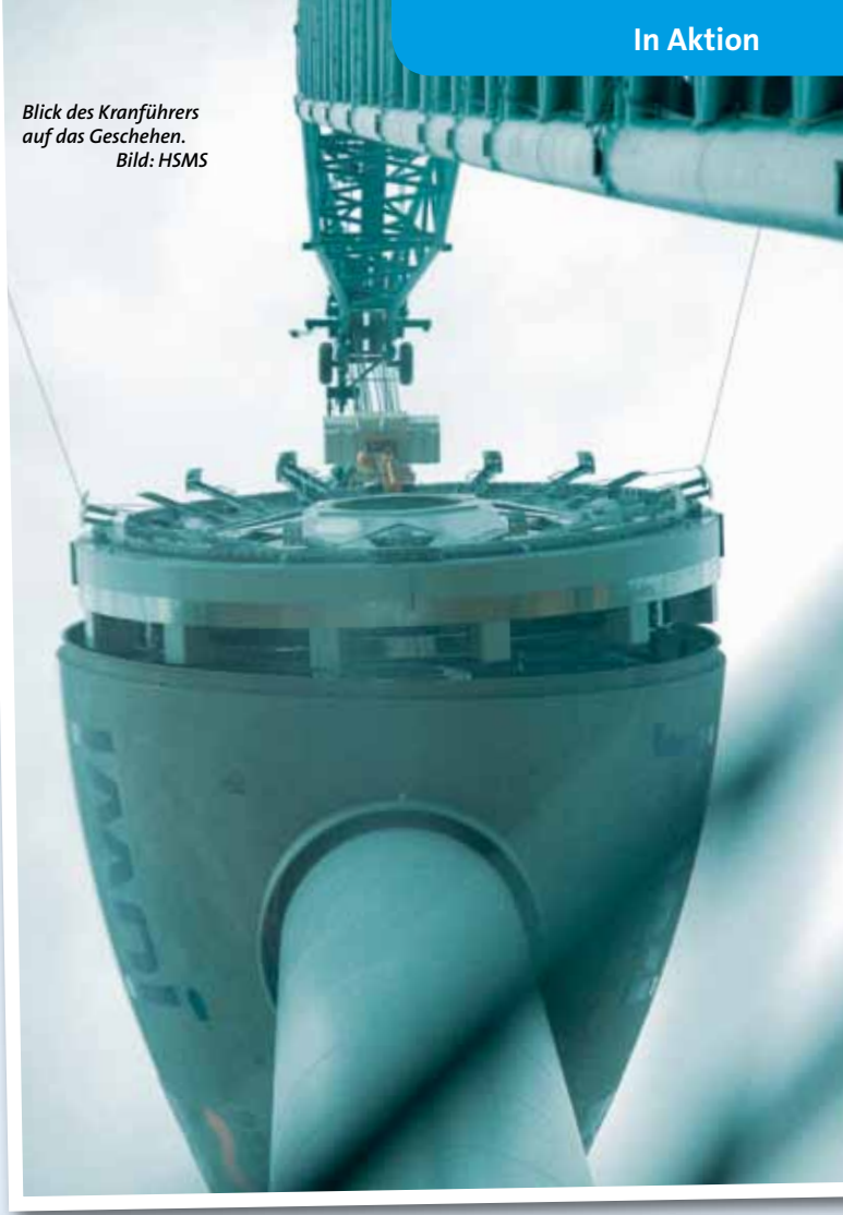
Etwa 140 t wiegt die Gondel der E 126 in diesem Vorfertigungszustand. Bild: Juwi
