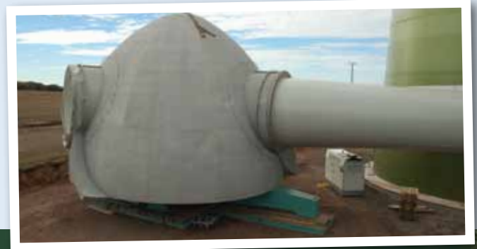
Die E 126 wird in vielen Einzelteilen geliefert, die vor Ort montiert werden. Kein Einzelteil wiegt mehr als 67 t. Bilder: HSMS
