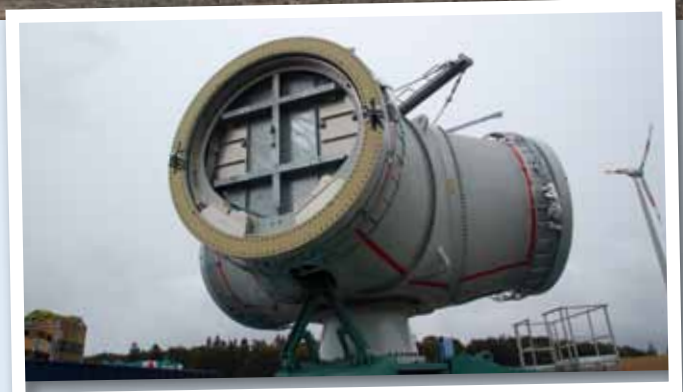
Die E 126 wird in vielen Einzelteilen geliefert, die vor Ort montiert werden. Kein Einzelteil wiegt mehr als 67 t. Bilder: HSMS
