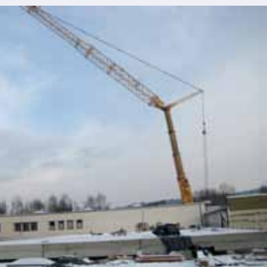
Ein 400-Tonner von Bracht platziert Stützen und Spannbetonhohldielen-platten.
