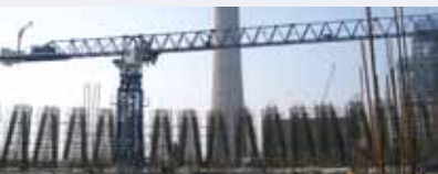
Im indischen Kalisindh ist dieser Comansa 21CJ290-18 t im Einsatz.
