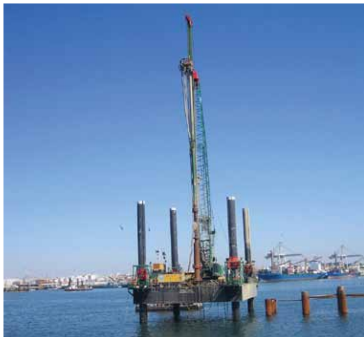
Ein Manitowoc-Raupenkran arbeitet auf einer Offshore-Plattform und platziert im Rahmen der Erweiterung des Hafens von Leixões (Portugal) Pfähle.
