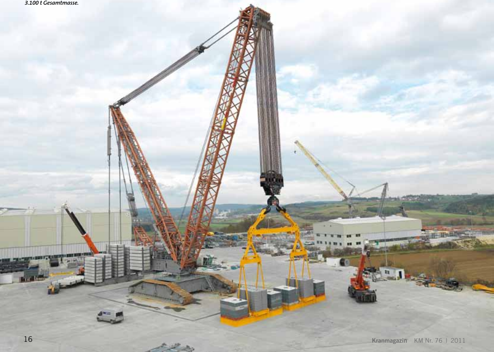
Der LR 13000 bei einem Testhub mit über 3.100 t Gesamtmasse.
