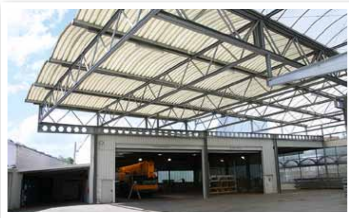
Große Maschinen, große Hallen. Die Krane werden nach den Vorgaben der Kunden lackiert.
