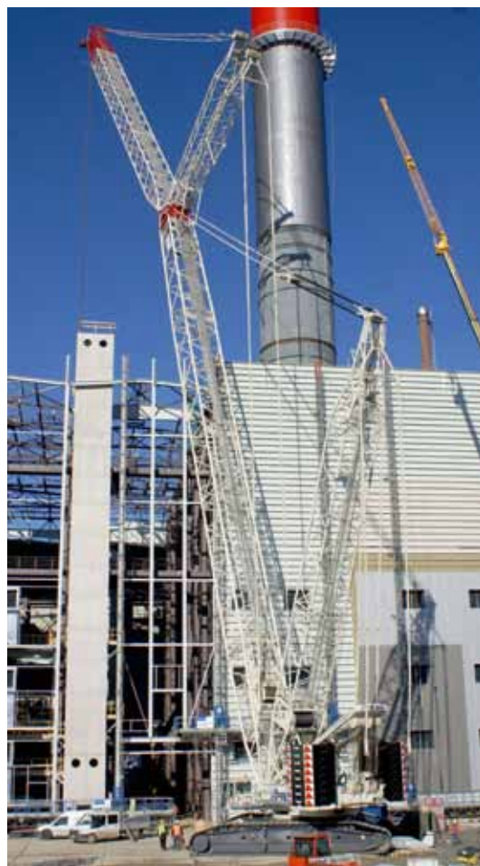
Ein CC 2800 im Einsatz im Kraftwerk Mellach. Dort wurden unlängst die im Durchmesser größten Stahlkamine Europas montiert.
