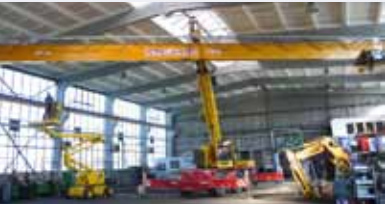
Konecranes übernimmt nicht nur Planung, Konstruktion und Bau des Krans, sondern auch die Montage.
