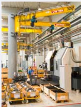
Alles im Fluss mit 22 Vetter-Schwenkkranen.
