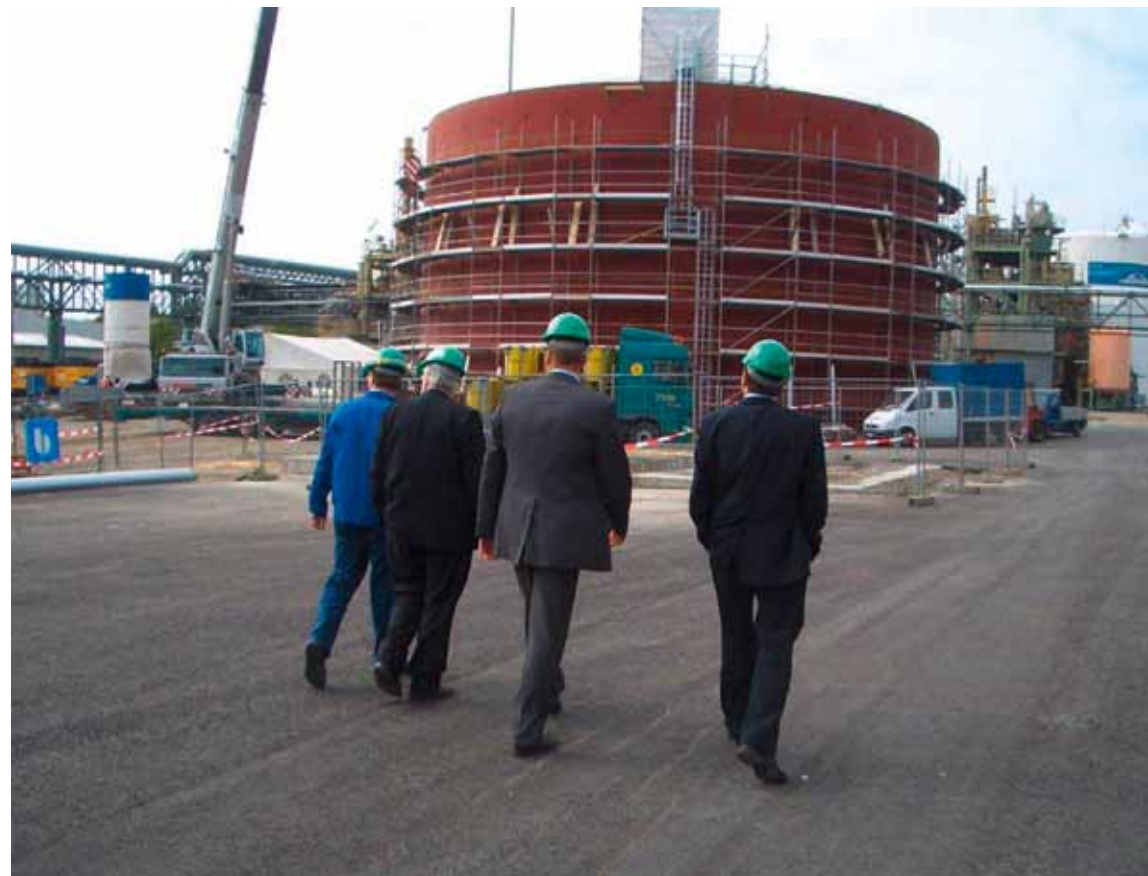
Mitarbeiter der S.D.L. Süddeutschen Leasing AG sind auch vor Ort aktiv. Hier wird eine Baustelle inklusive der finanzierten Objekte besichtigt.
