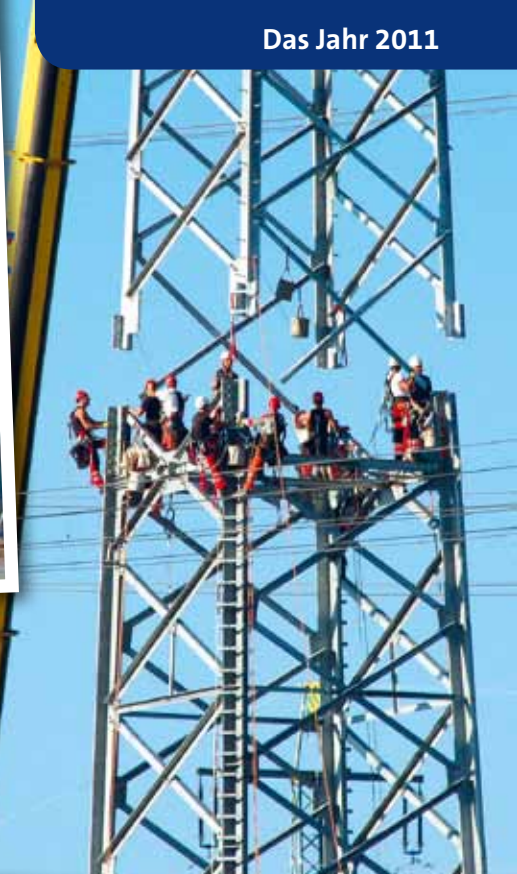
Stück für Stück wächst der Strommast. Bild: Hermann Schulte
