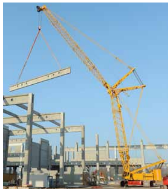
Wiesbauer brachte auf dem Mönchhofgelände in unmittelbarer Nähe zum Frankfurter Flughafen seinen Sennebogen 7700 Raupenkrane zum Einsatz.
