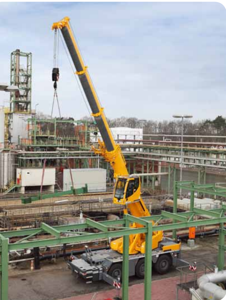
Nachfrageverschiebung: Der Trend geht zu größeren Kranen.
