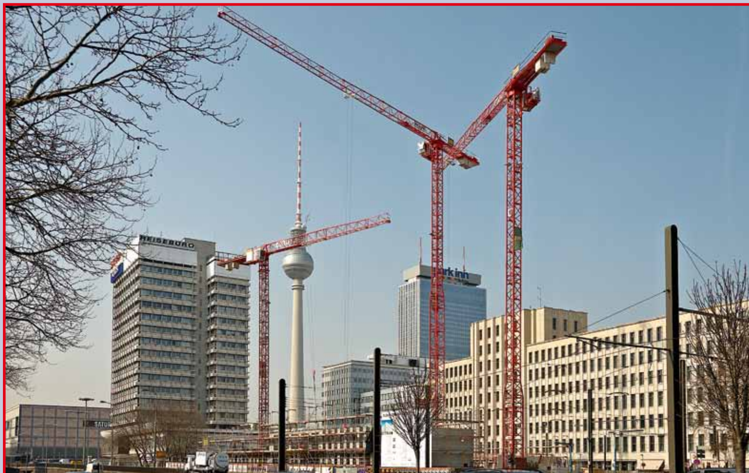
Einsatz in Berlin: bis zu drei Wolff 6015 clear halfen bei der Errichtung der Hotelanlage Alexander Parkside.
