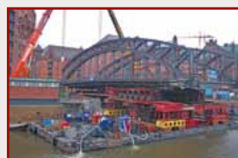
019 In Aktion: Schwimm- Brücke, schwimmt!
