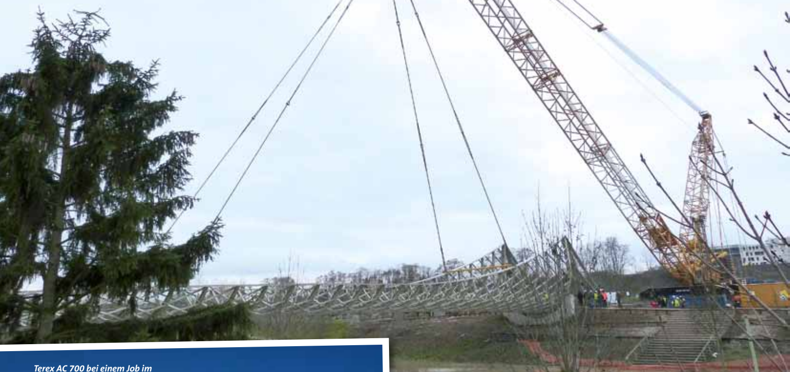
Terex AC 700 bei einem Job im Rahmen des Neubaus des neuen Stadions von Juventus Turin.
