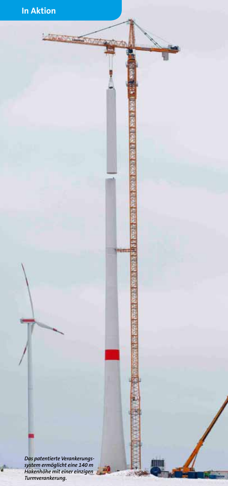
Mit bis zu 70 t Tragkraft ist der Turmdrehkran für die Montage moderner Schwachwind-Windkraftanlagen gerüstet.
