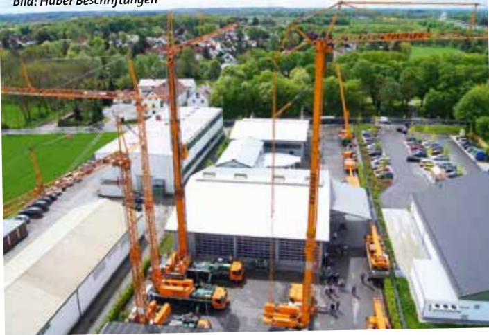
Auch mobile Baukrane gehören zur Kranflotte. Bild: Huber Beschriftungen
