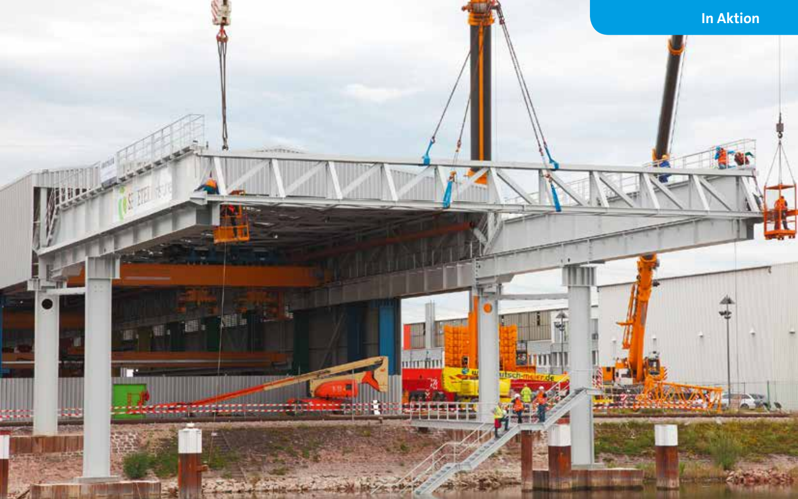
Bis zur Fertigstellung verarbeitet und montiert Freyler für die Halle sowie die Kranbahnträger insgesamt 915 Tonnen Stahl.
