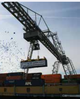
Die neu eingeweihte Containerbrücke bietet 17 m Hubhöhe.
