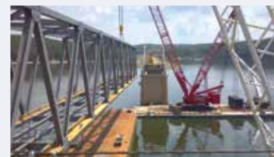
Der auf einem Ponton montierte Kobelco SL4500R beim Einheben eines Brückensegments.
