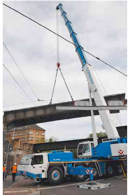
ATF 220G-5 bei der Demontage einer Eisenbahnbrücke unter beengten Platzverhältnissen. Verschiedene Oberleitungen, Straßenschilder und Ampelanlagen behinderten den Standplatz und die Bewegungsfreiheit des Krans.
