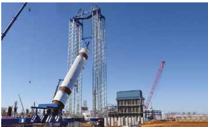
Hubgerüst für schwerste Lasten: nur eine von vielen Lösungen von Enerpac.
