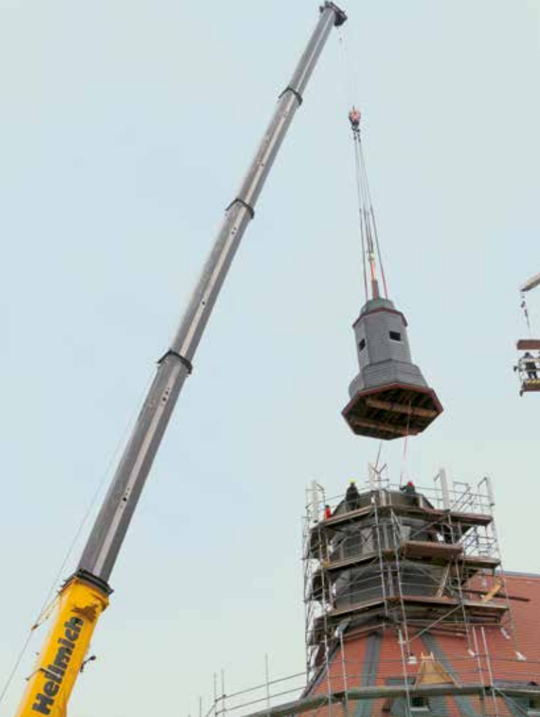
Mit Fingerspitzengefühl bewegt der Kranfahrer die restaurierte Haube. Auf der Turmspitze stehen zwei Monteure und helfen bei der richtigen Positionierung.
