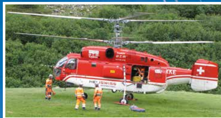
Für die Montage kam der Schwerlasthelikopter Kamov KA 32 A12 der Firma Heliswiss zum Einsatz.
