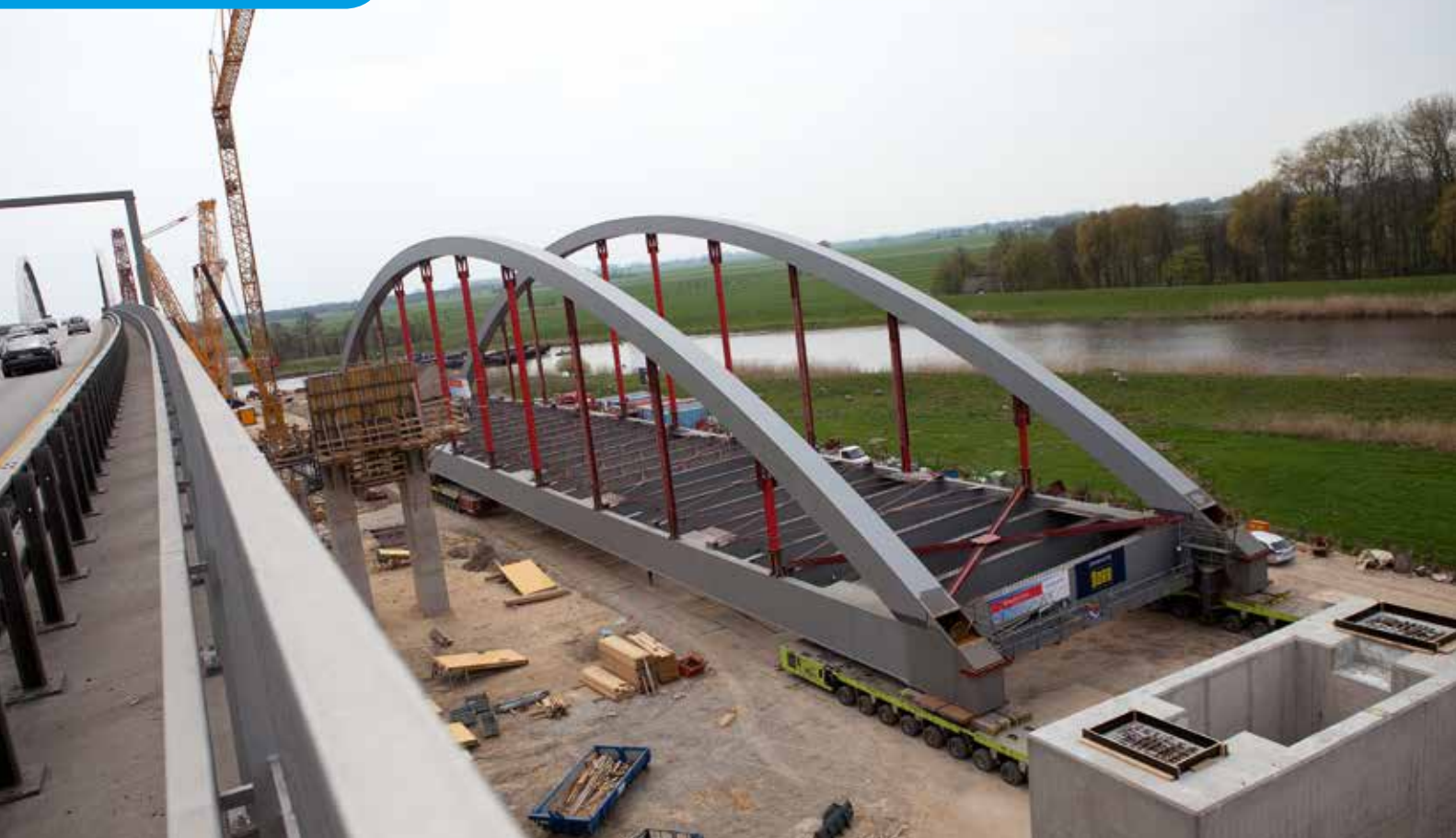
▲ Nachdem die Brücke auf Selbstfahrem zur Baustelle gelangt war, wurde der vordere Teil auf ein Ponton aufgefahren. ▼
