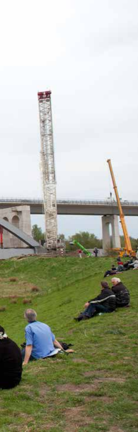
Die drei Raupenkrane mussten bei dem Brückenhub absolut synchron arbeiten. Der Superlift 3800 hob den größten Teil des Brückengewichts.
