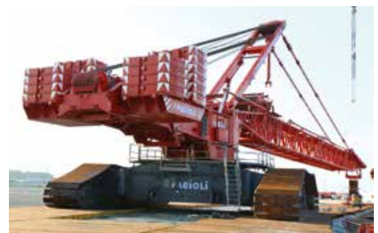
Damit der Kran entlang der Kaimauer fahren kann, wurde eine sandunterfütterte Fahrbahn für die Raupenfahrwerke installiert. Bild: Jens Hadel.
