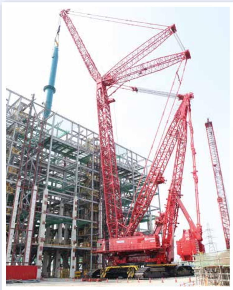
Manitowoc 31000 im Einsatz im Kraftwerk von Posco E&C in Südkorea.
