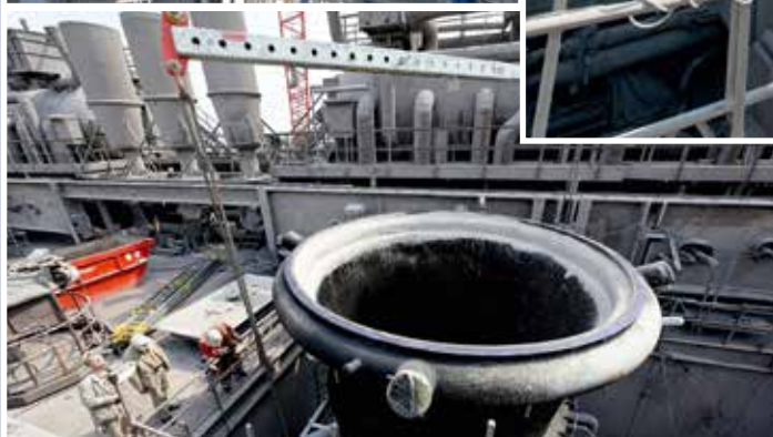
Durch eine Öffnung im Dach des Stahlwerks wird das Oberteil des Abhitze-kessels in die Converterhalle abgesenkt.
