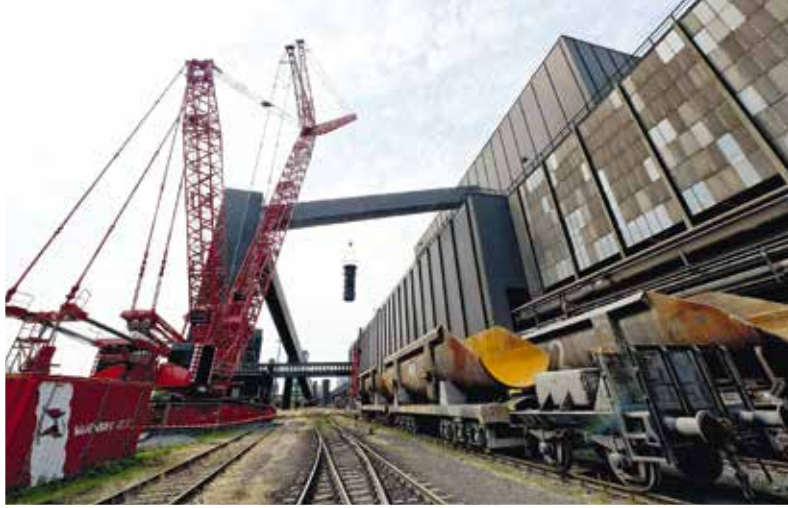
Das 28 t schwere Oberteil des Abhitzeessels wird in rund 80 m Höhe durch das Dach des Stahlwerks gesenkt.
