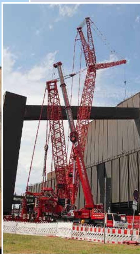
Einhub des letzten Bauteils: Die über 40 t schwere Umlenkung für das neue Abhitzesystem schwebt seinem endgültigen Bestimmungsort entgegen.
