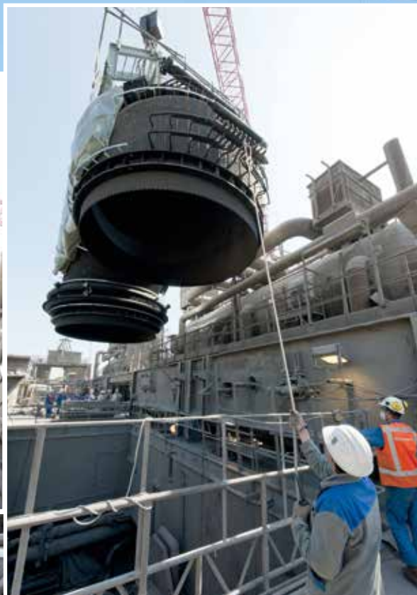
Durch eine Öffnung im Dach des Stahlwerks wird das Oberteil des Abhitze-kessels in die Converterhalle abgesenkt.
