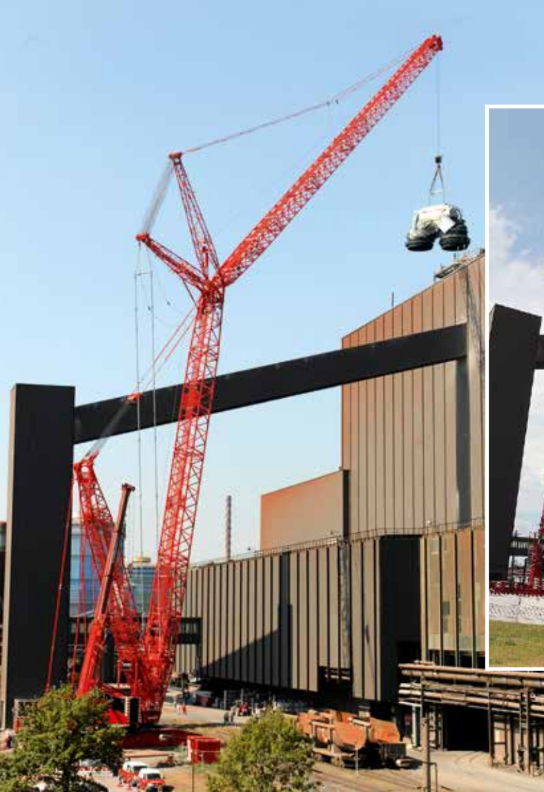
Einhub des letzten Bauteils: Die über 40 t schwere Umlenkung für das neue Abhitzesystem schwebt seinem endgültigen Bestimmungsort entgegen.
