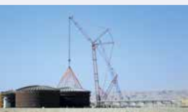
Hub eines 150 t schweren Wassertanks.
