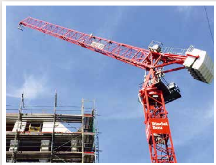
Der Ausleger des Wolff 166 B lässt sich fast senkrecht aufstellen.
