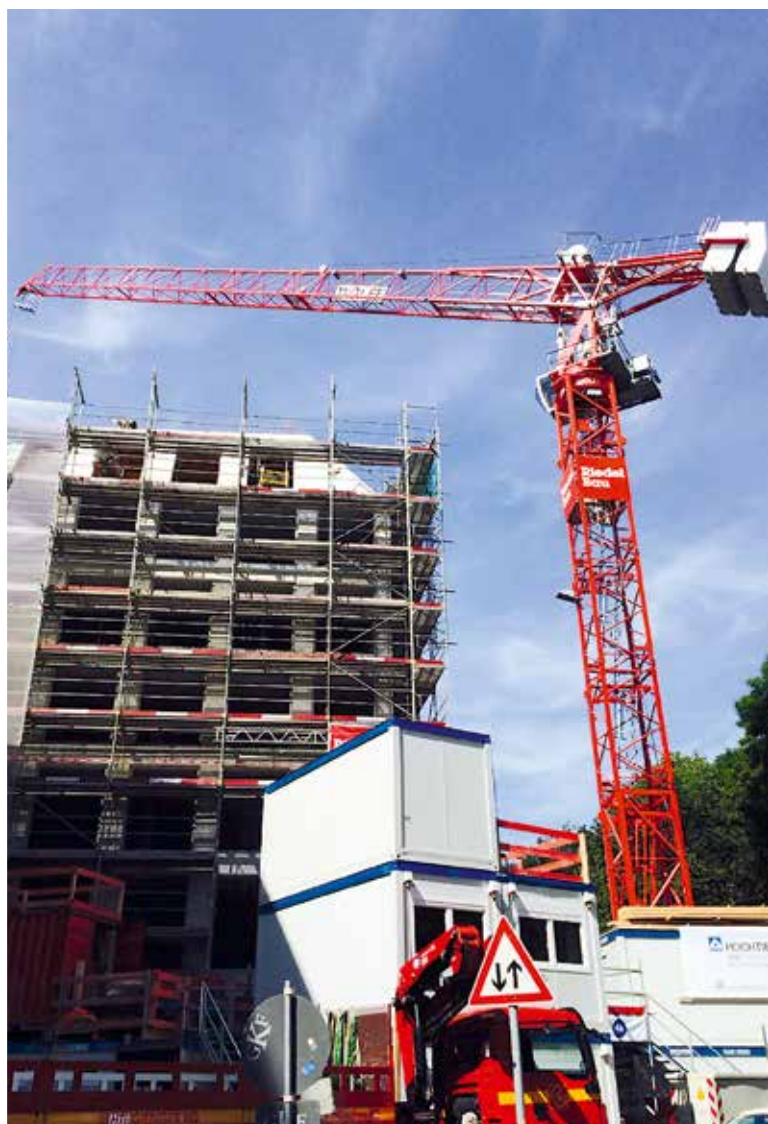
Dank seiner Kompaktheit eignet sich der Wolff 166 B bestens für Arbeiten unter beengten Platzverhältnissen, und auch für die Kranmontage selbst wird wenig Platz benötigt.
