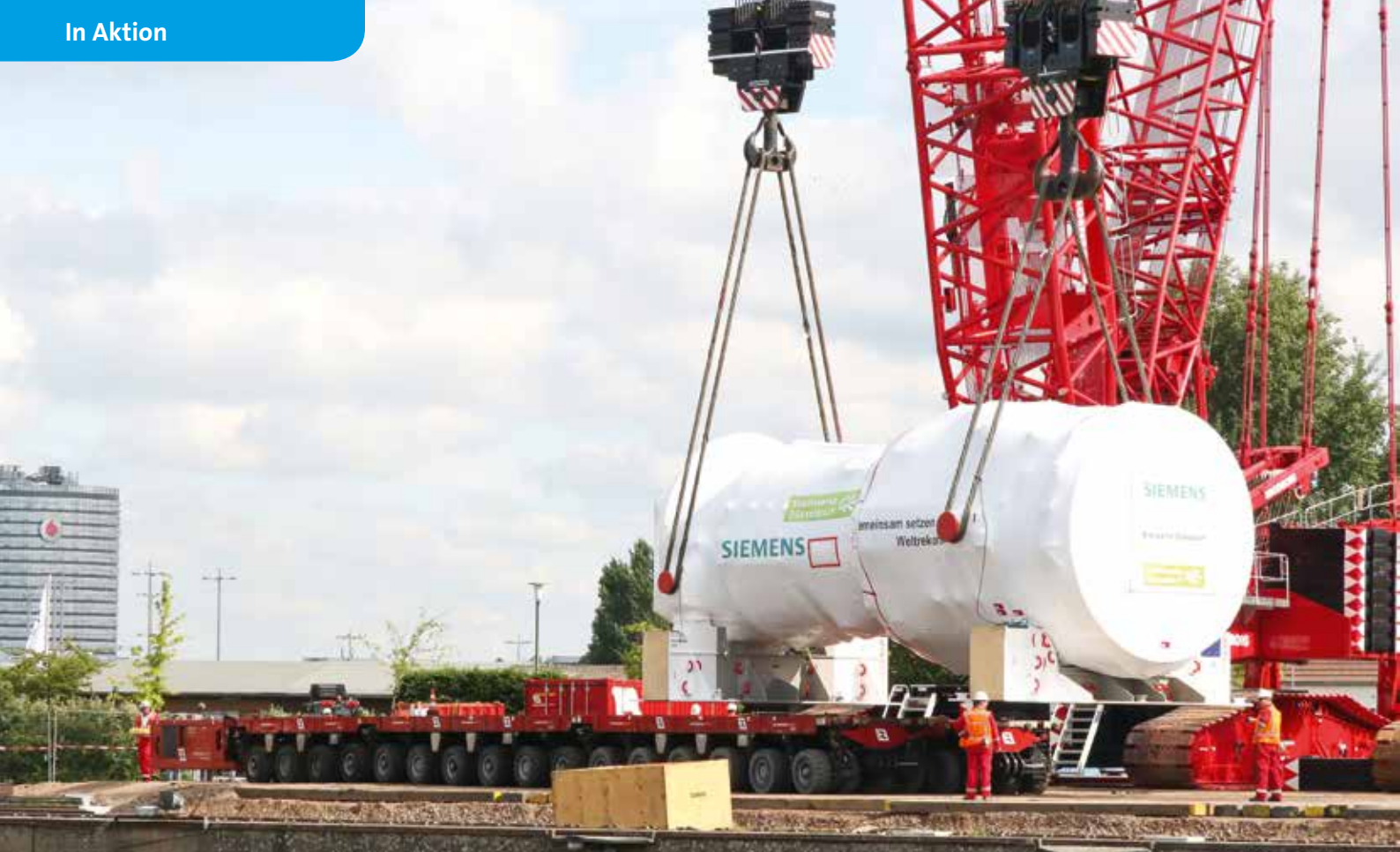
Ausheben des Generators sowie der Gasturbine.
