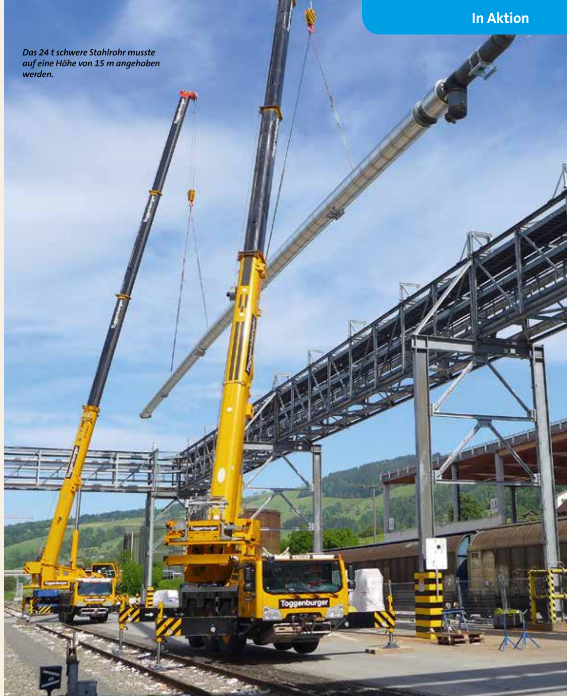
Die Terex-Krane Challenger 3180 und AC 100/4L kamen jeweils mit 35 m Hauptausleger zum Einsatz.
