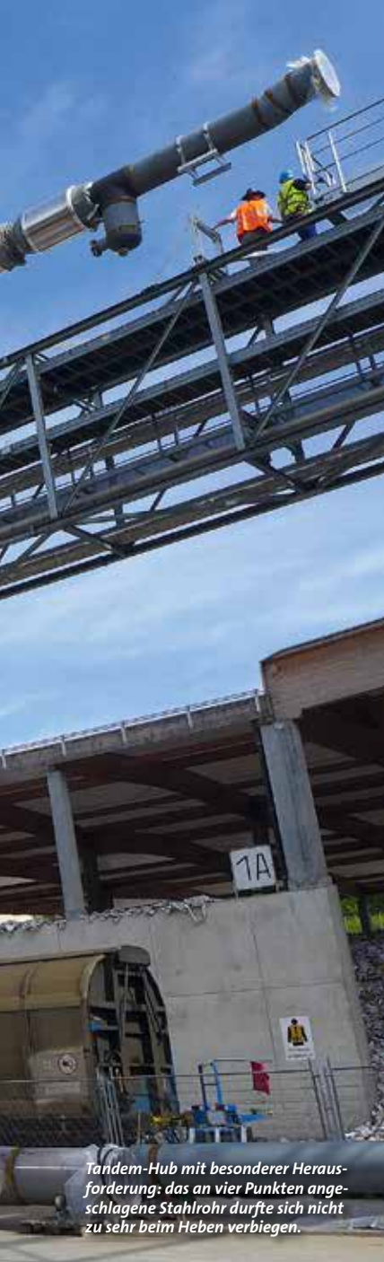
Das 24 t schwere Stahlrohr musste auf eine Höhe von 15 m angehoben werden.
