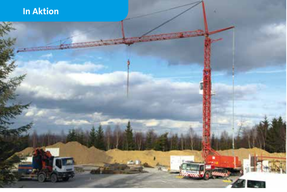
Fleißiger Helfer: Der MK 80 als Kran für den Fundamentbau.
