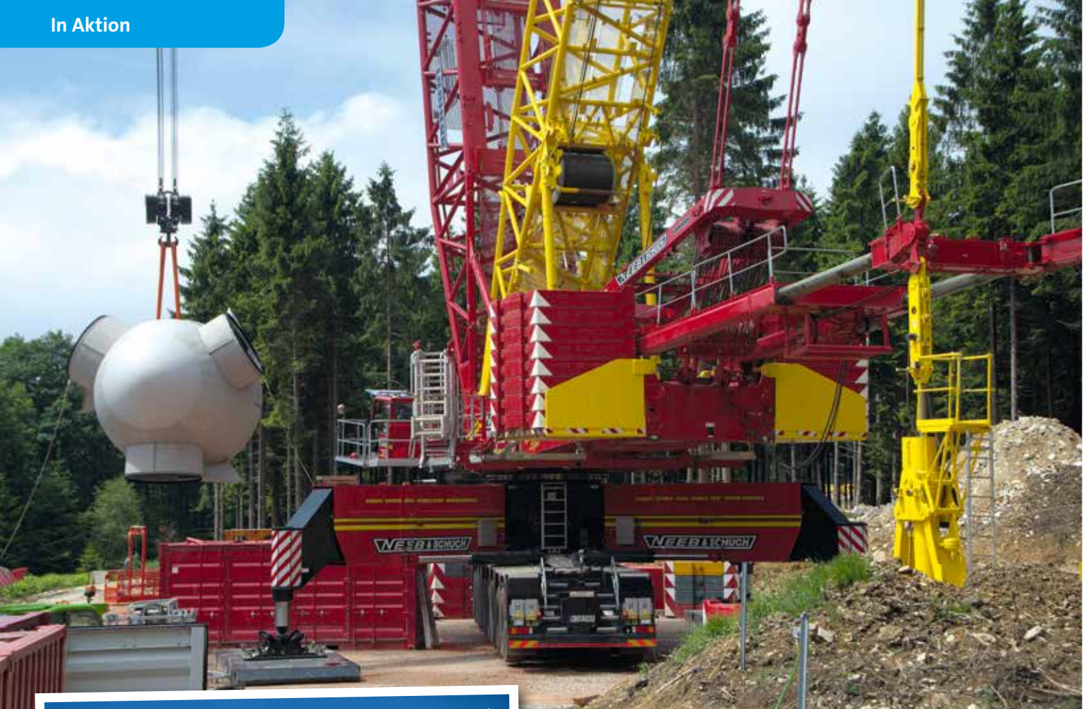
Endspurt – die Nabe, der Rotor – fertig.
