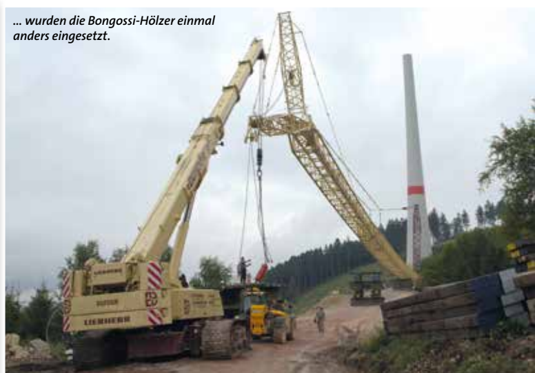
...für die Montage dieses Gittermastes ...
