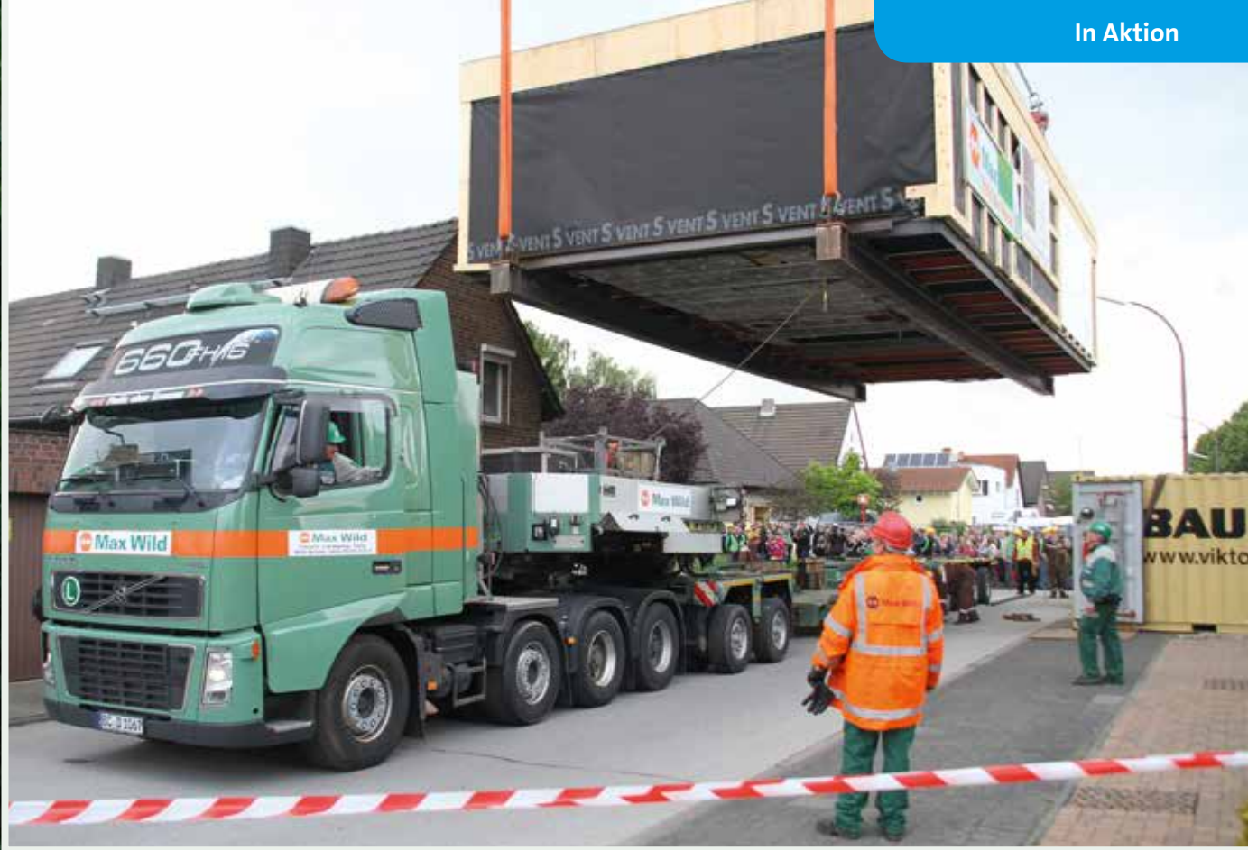
Per Autokran wird das erste Quelle Fertighaus „Typ 100“ auf den Tieflader gehoben.
