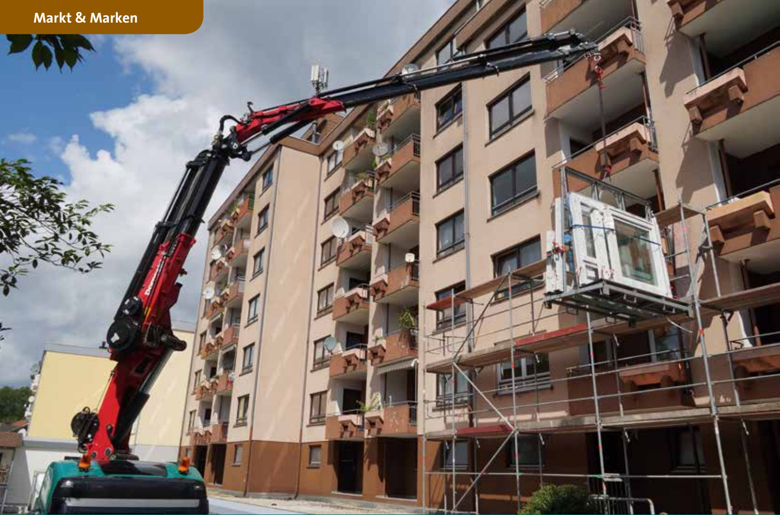
Mit dem Knickarm eignet sich der HMF-Ladekran hervorragend für Einsätze an Störkanten und bestehenden Gebäudehüllen.
