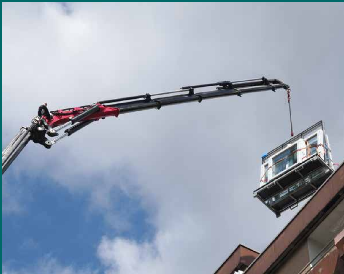
Mit dem Knickarm eignet sich der HMF-Ladekran hervorragend für Einsätze an Störkanten und bestehenden Gebäudehüllen.
