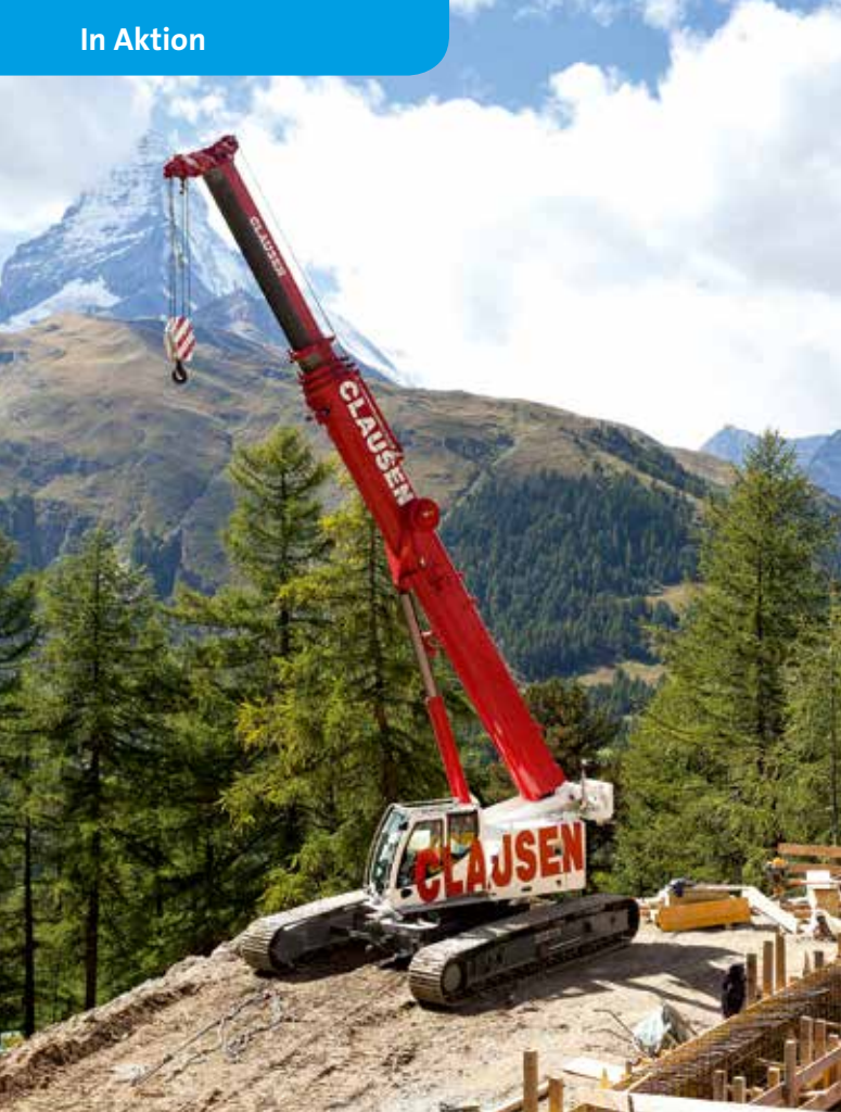
Am Ziel: Vor der Kulisse des Matterhorns arbeitet der LTR 1060 an der Überdachung eines Bergbahn-Tunnels.
