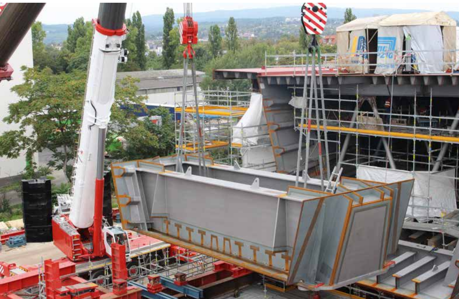
Bis zu 53,5 t Netto-Lastgewicht auf 16 m Radius hatte der ATF 400G-6 am Haken.
