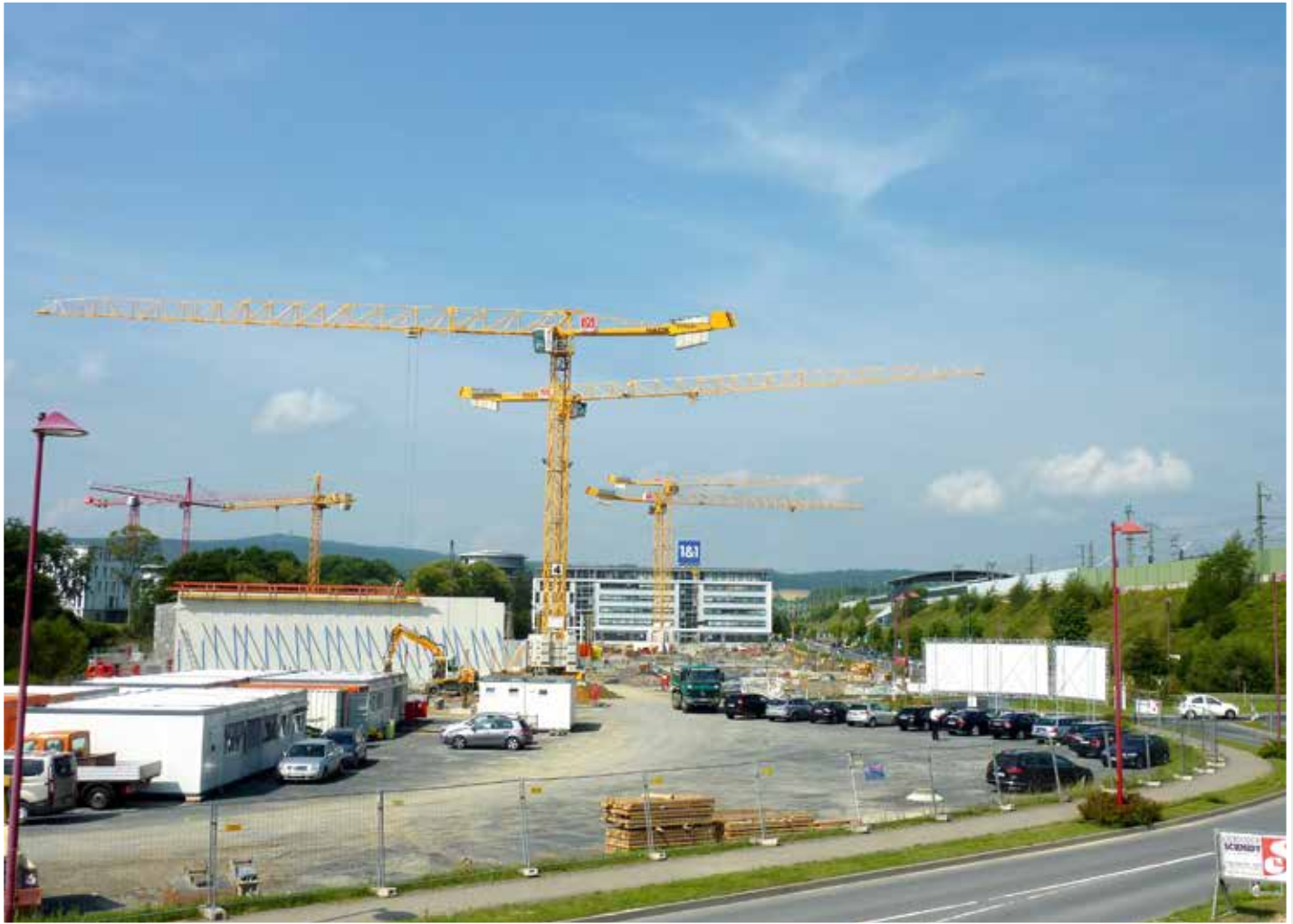
Vier werksneue POTAIN Turmdrehkrane sichern die ausgeklügelte Baustellenlogistik beim Bau des Fashion Outlet Centers in Montabaur.
