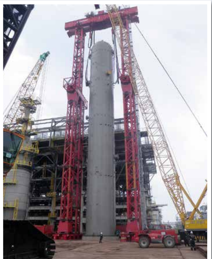
Nach fünf Stunden ist es geschafft: der Absorber steht an Ort und Stelle.
