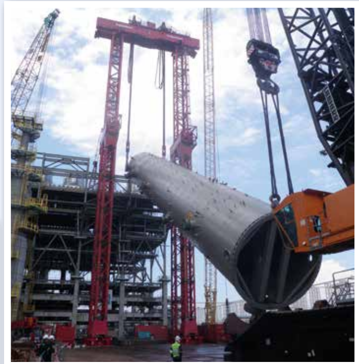
Vorne Gantry System, hinten Liebherr-Raupenkrane.
