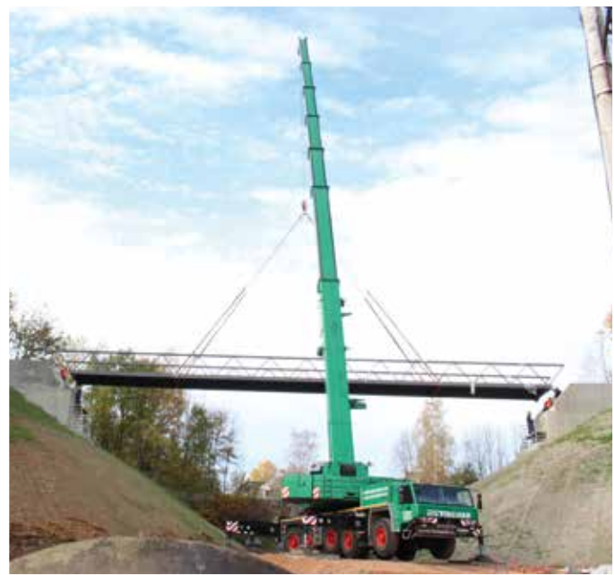
Die Landesgartenschaubrücke ist 35 m lang und 24 t schwer. Bei dem Einsatz steht dem ATF 220G-5 nicht besonders viel Platz zur Verfügung.
