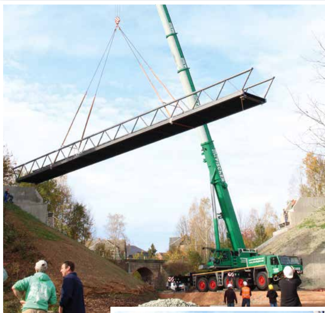
Die Landesgartenschaubrücke ist 35 m lang und 24 t schwer. Bei dem Einsatz steht dem ATF 220G-5 nicht besonders viel Platz zur Verfügung.
