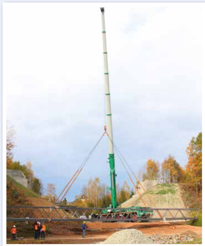
Die Landesgartenschaubrücke ist 35 m lang und 24 t schwer. Bei dem Einsatz steht dem ATF 220G-5 nicht besonders viel Platz zur Verfügung.
