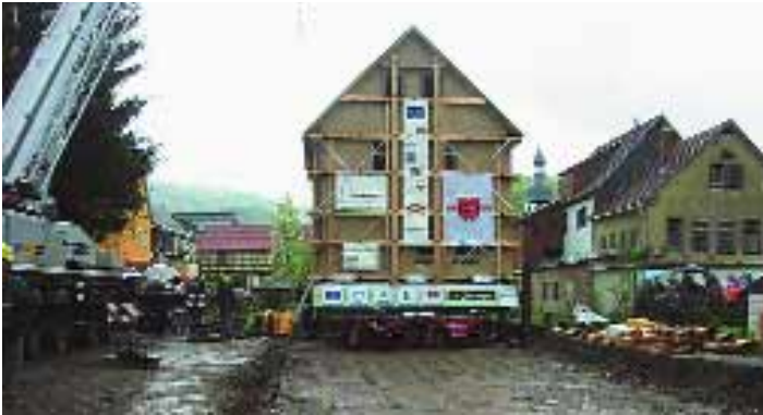
Historische Fracht ruht auf moderner Technik: auf SPMTs mit 2 x 10 parallel geschalteten Achsen transportierte Riga Mainz diese historische Korkenzieherwerkstatt.
