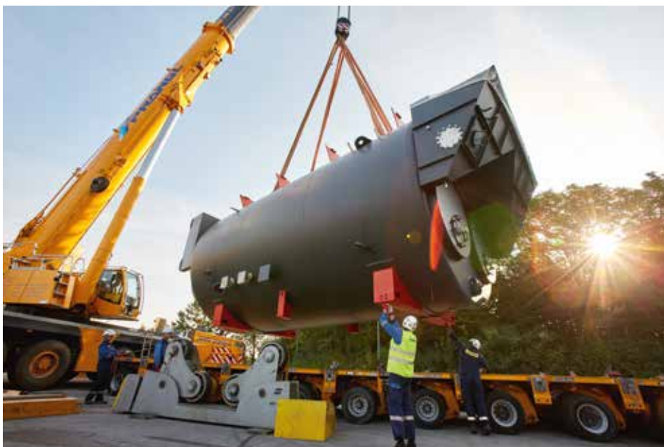
Mit einem 350 Tonnen Teleskopkran wurden die Kessel auf die Selbstfahrer geladen.
