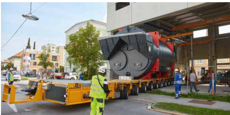
Am Zielort wurde mithilfe eines Hubportals der Kessel vom Selbstfahrer gehoben.
