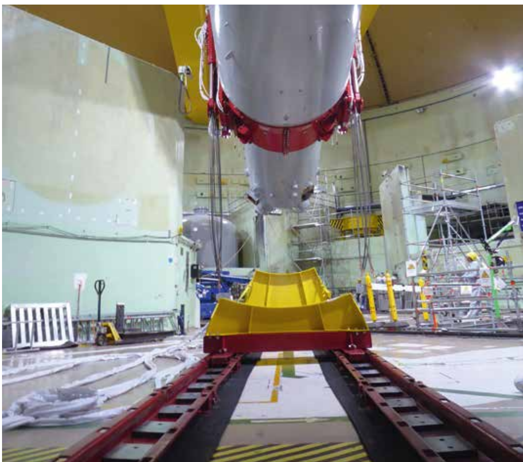
Ein Dampferzeuger wird auf das Mammoet Verschiebesystem aufgesetzt. Foto: EnBW Kernkraft GmbH
