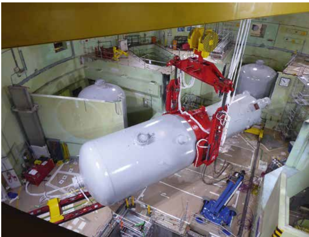
Ein Dampferzeuger wird mit dem Mammoet DHS-500 kontrolliert um seine Querachse gekippt.
