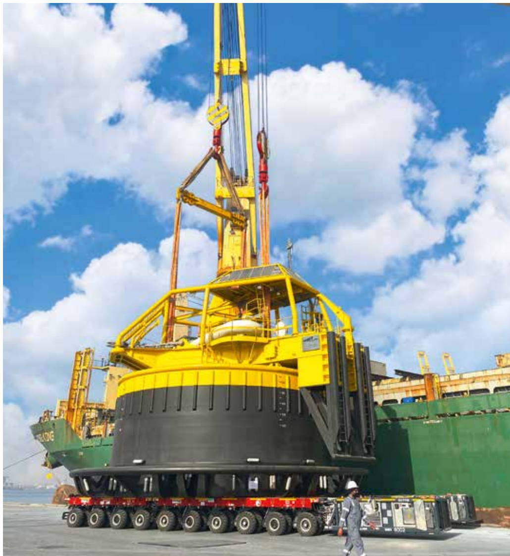
Mithilfe eines Schiffskran wurden die Bojen entladen.
