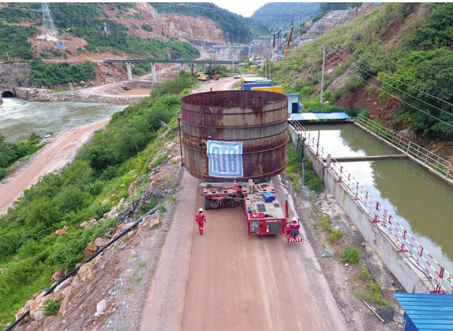
Insgesamt 50 Rohrabschnitte mussten zum Bestimmungsort gebracht werden.
