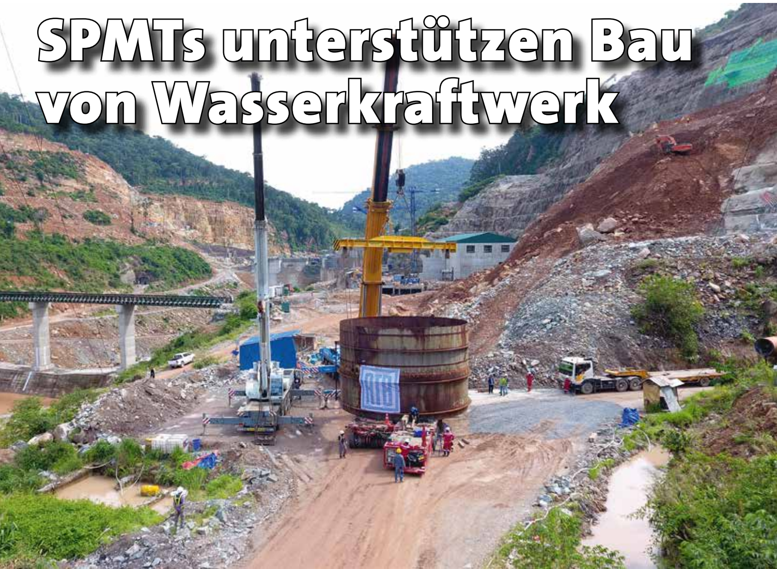
Ein Mobilkran hebt am Zielort die Rohrsegmente von den SPMTs.
