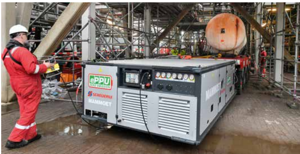
Das alte Gefäß ist auf den zwei vorderen Achsen des SPMTs gesichert ...
