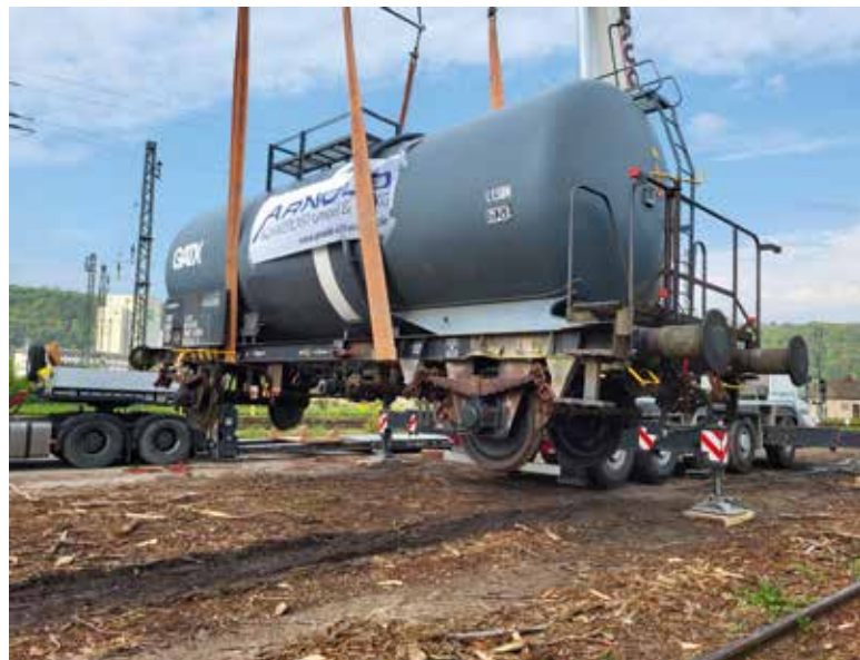
Mit Hilfe eines Autokrans wurden die beiden Eisenbahnwaggons auf bzw. vom Tieflader gehoben. Foto: Arnold
