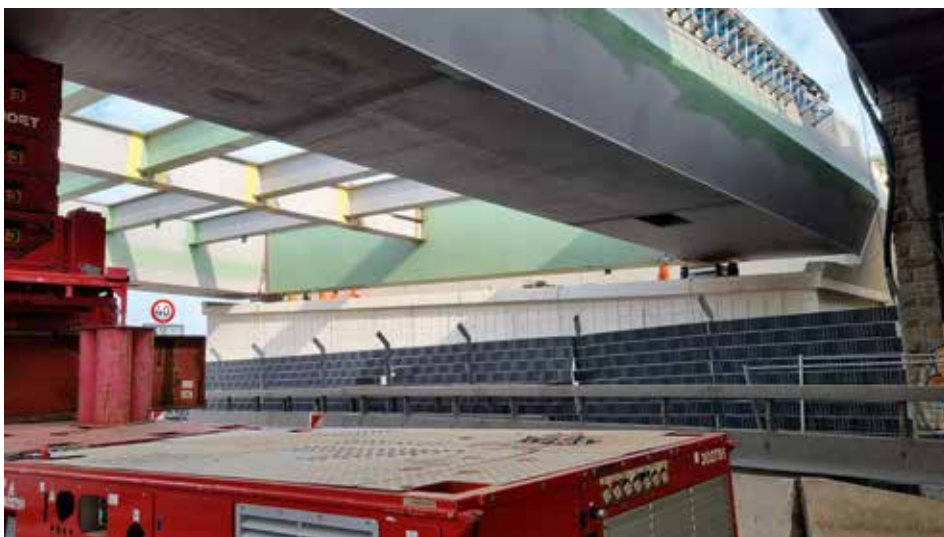
Abgesenktes Brückensegment mit Neigung in Längsrichtung.
