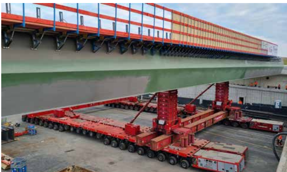
Das Brückensegment wird über die Widerlager gefahren.
