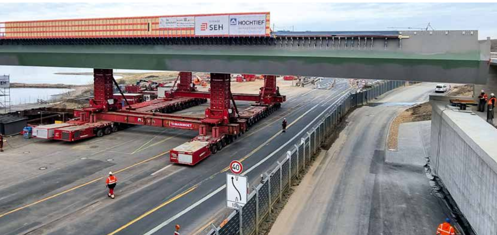
Die Brücke hatte sowohl eine Quer- als auch eine Längsneigung.
