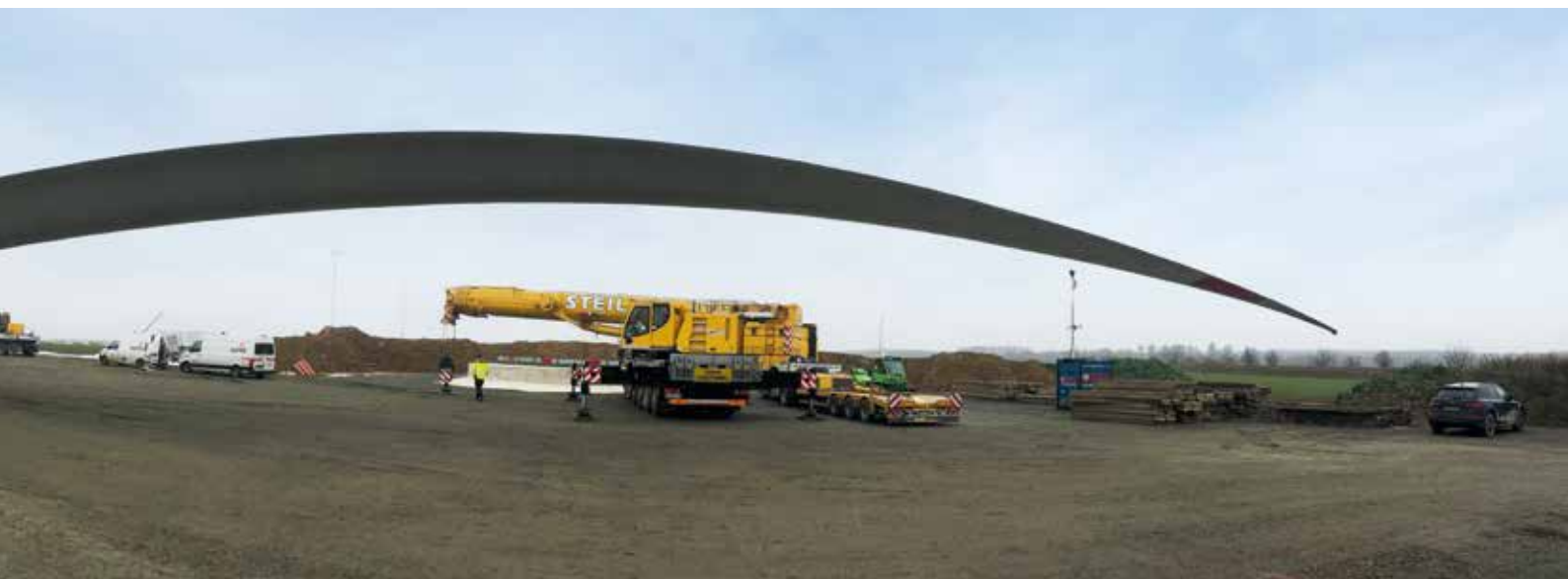
Die zu transportierenden Rotorblätter hatten eine Länge von bis zu 79 m.
