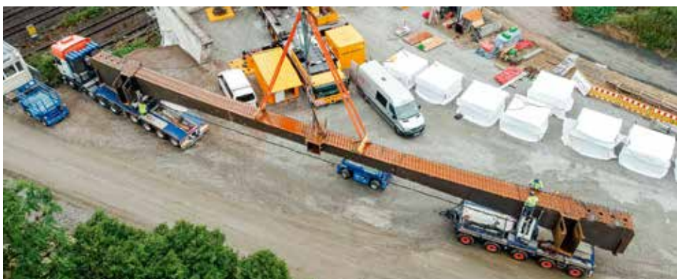
In Paderborn angekommen wird der Brückenträger an der Baustelle abgeladen.
