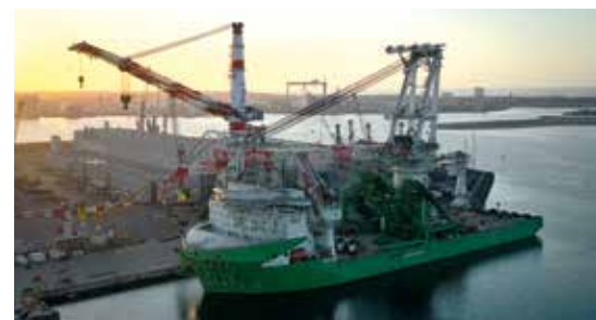
Offshore-Schiff „Orion“ mit dem montierten Liebherr-Kran HLC 295000.
