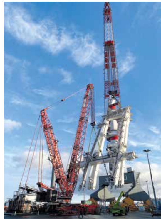
Heavy Lift des A-Frame.
