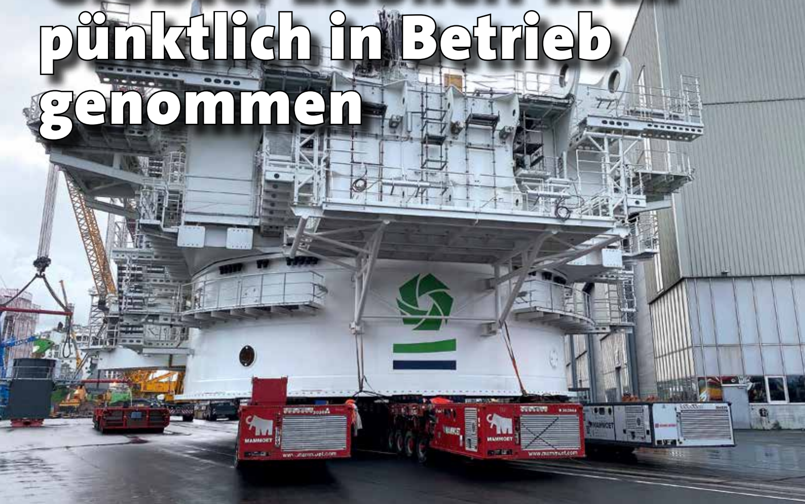
SPMT-Transport der 1.850 t schweren Drehbühne.
