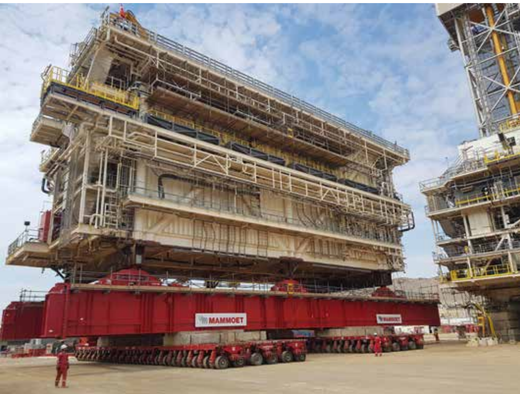
Für den Transport kamen SPMTs zum Einsatz.
