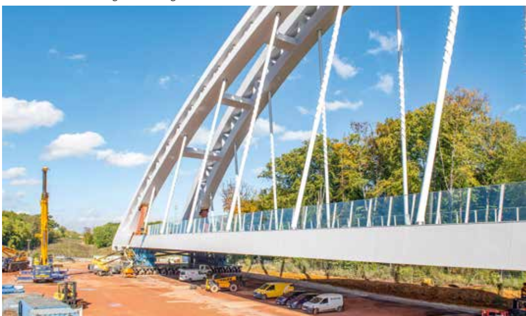
Die 200 Meter lange, 18,5 Meter breite, 40 Meter hohe und 5.850 Tonnen schwere Brücke steht bereit, um in der Nacht an die Endposition verschoben zu werden.
