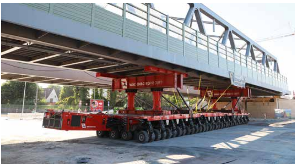
Die zweite Brücke muss nur noch auf die Widerlager abgelassen werden.
