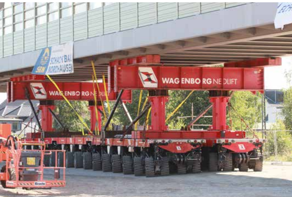
Mit der zweiten Brücke ging es über eine zuvor präparierte Schotterstraße, die teilweise mit Stahlplatten ausgelegt war.
