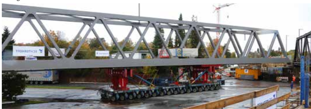
Am Zielort angekommen, wird die Brücke gedreht ...
