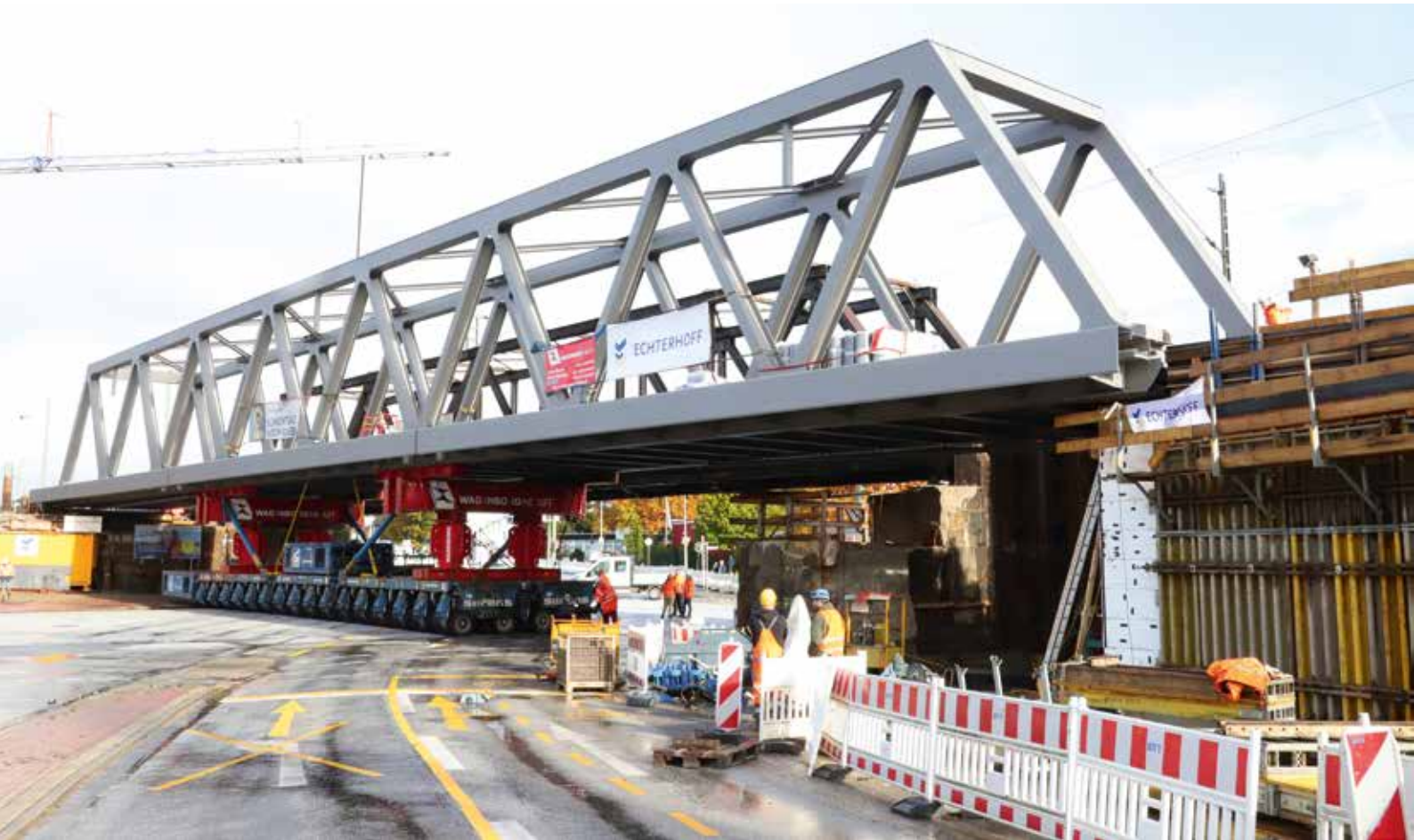
... und auf den Widerlagern platziert.
