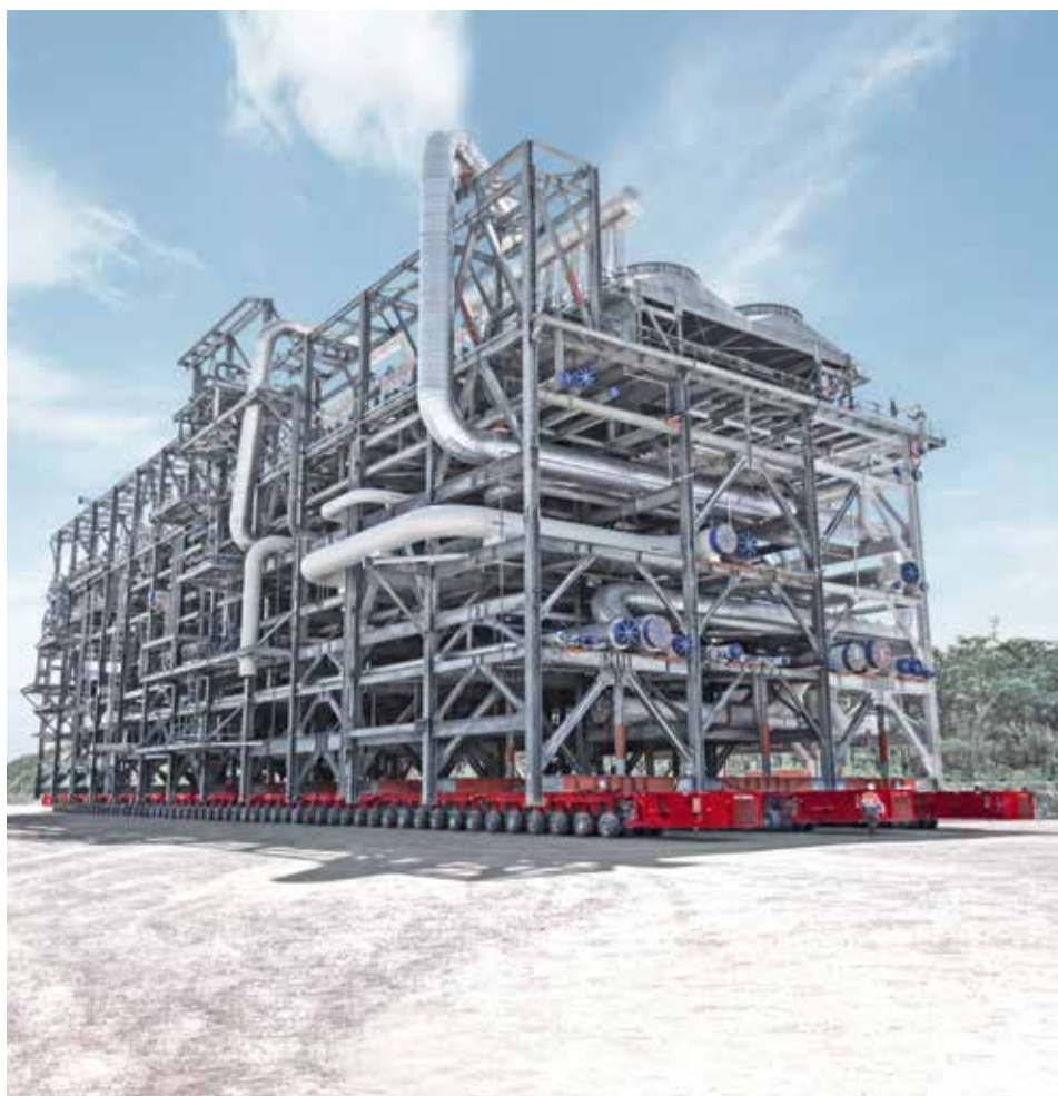
TII Scheuerle-SPMT im Einsatz bei einer Schwerlastmontage.
